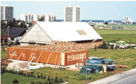
Bau des Pfarr- und Jugendheims „Oase“, 1978
